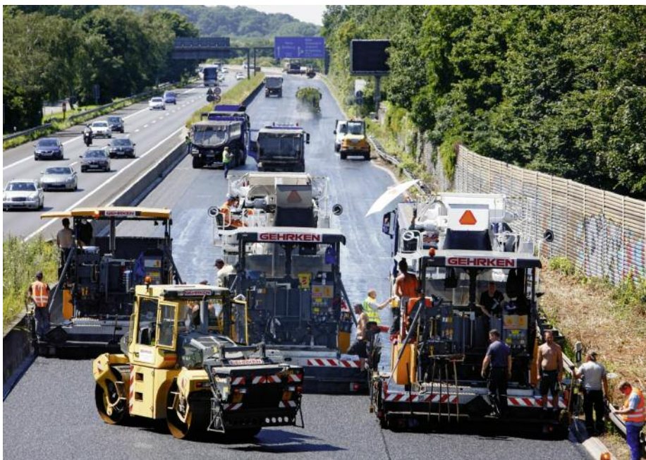
Autobahnbaustelle in Nordrhein-Westfalen
