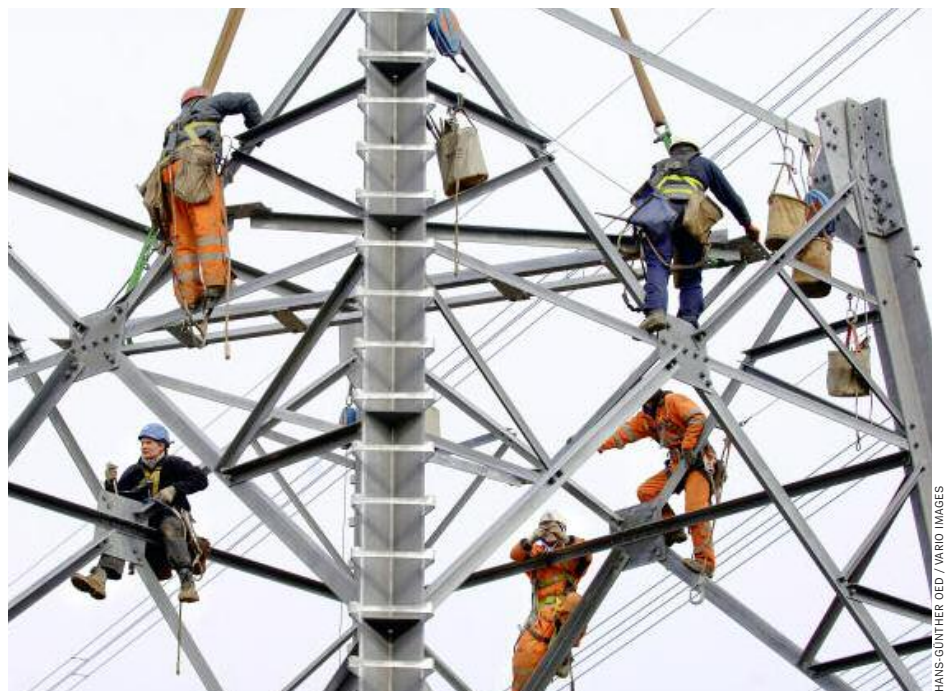
Bau eines Hochspannungsmastes: „Wir planen mit Hochdruck neue Trassen“
