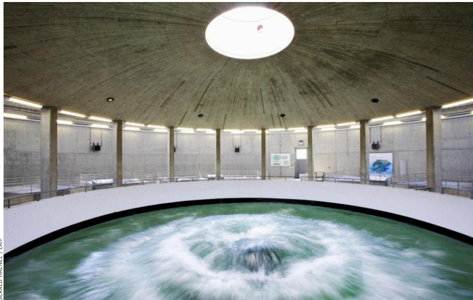
Wasserwerk am Bodensee: Fauliger Gestank aus der Kanalisation
