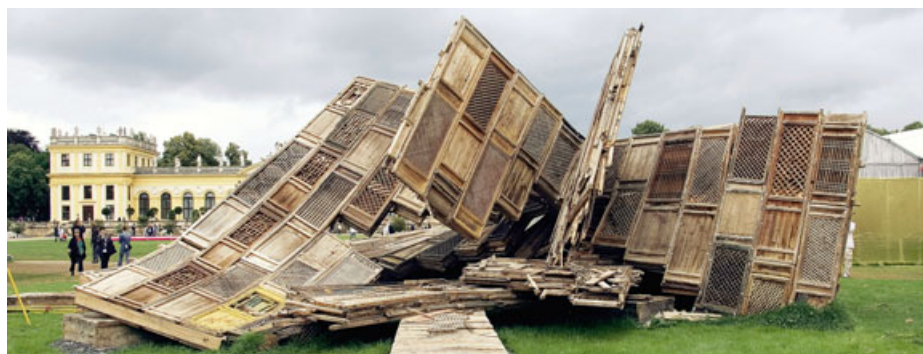
Zusammengefallener Documenta-Turm in Kassel, 2007
