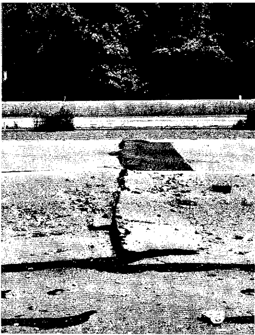
Hitzeschaden auf der Autobahn Schock bei 70 Grad
