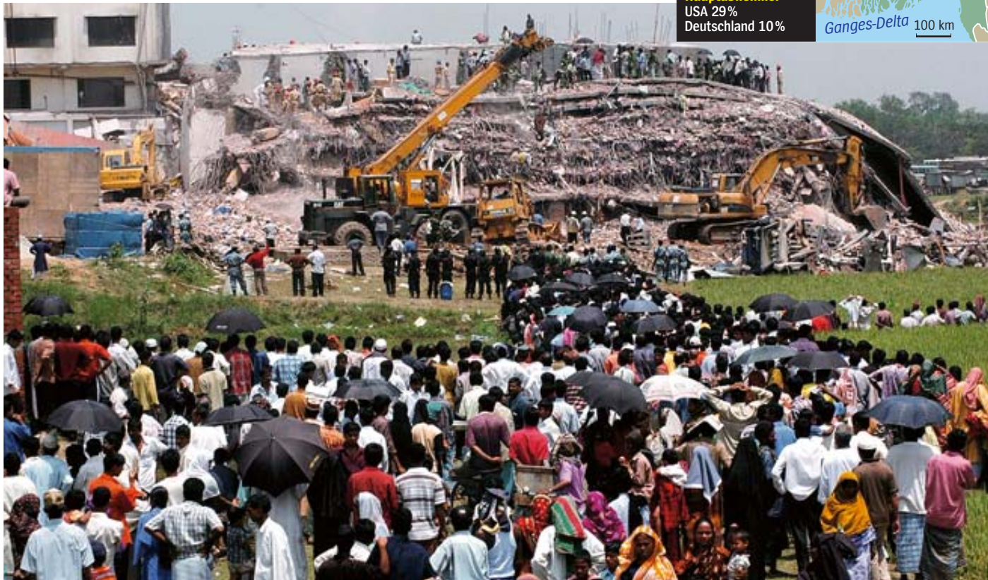
Eingestürzte Textilfabrik in Savar: Das Mauerwerk sackte einfach weg
