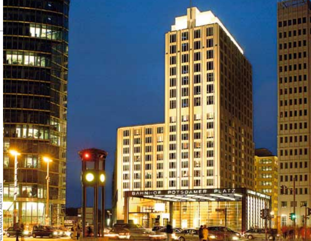
Beisheim-Center (am Potsdamer Platz in Berlin): Denkmal für 460 Millionen Euro
