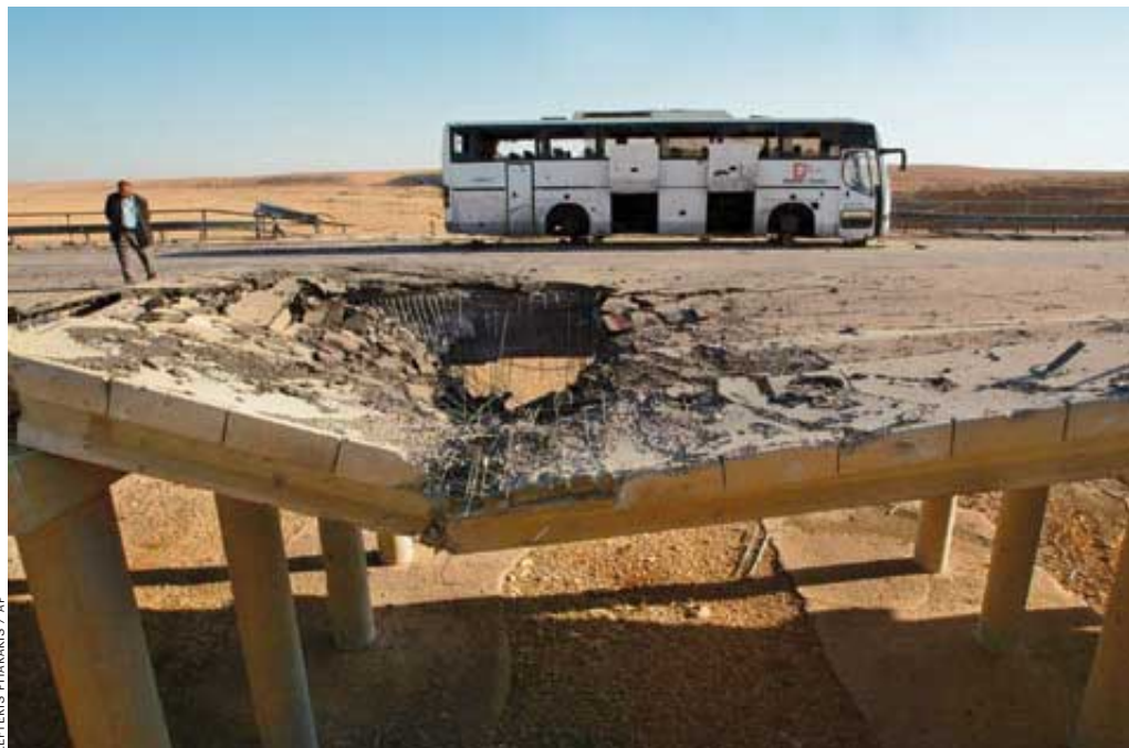
Kriegsschäden im Irak (Straße nach, Kraftwerk in Bagdad), Babcock-Borsig-Zentrale in Oberhausen:
