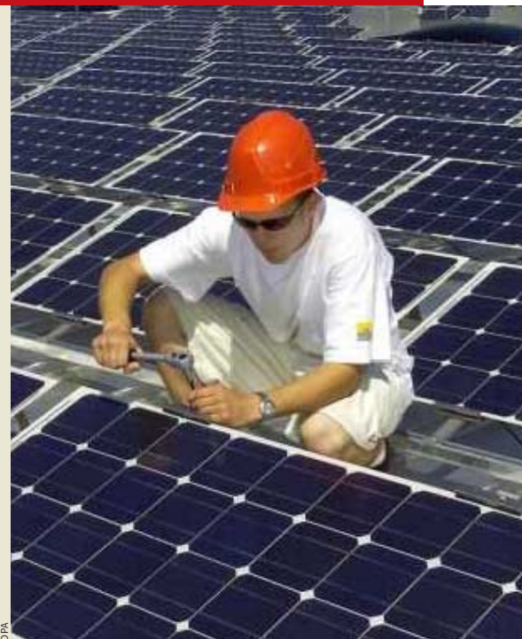
Montage von Solarmodulen
