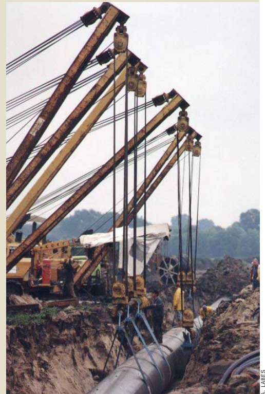
Bau einer Erdgasleitung
