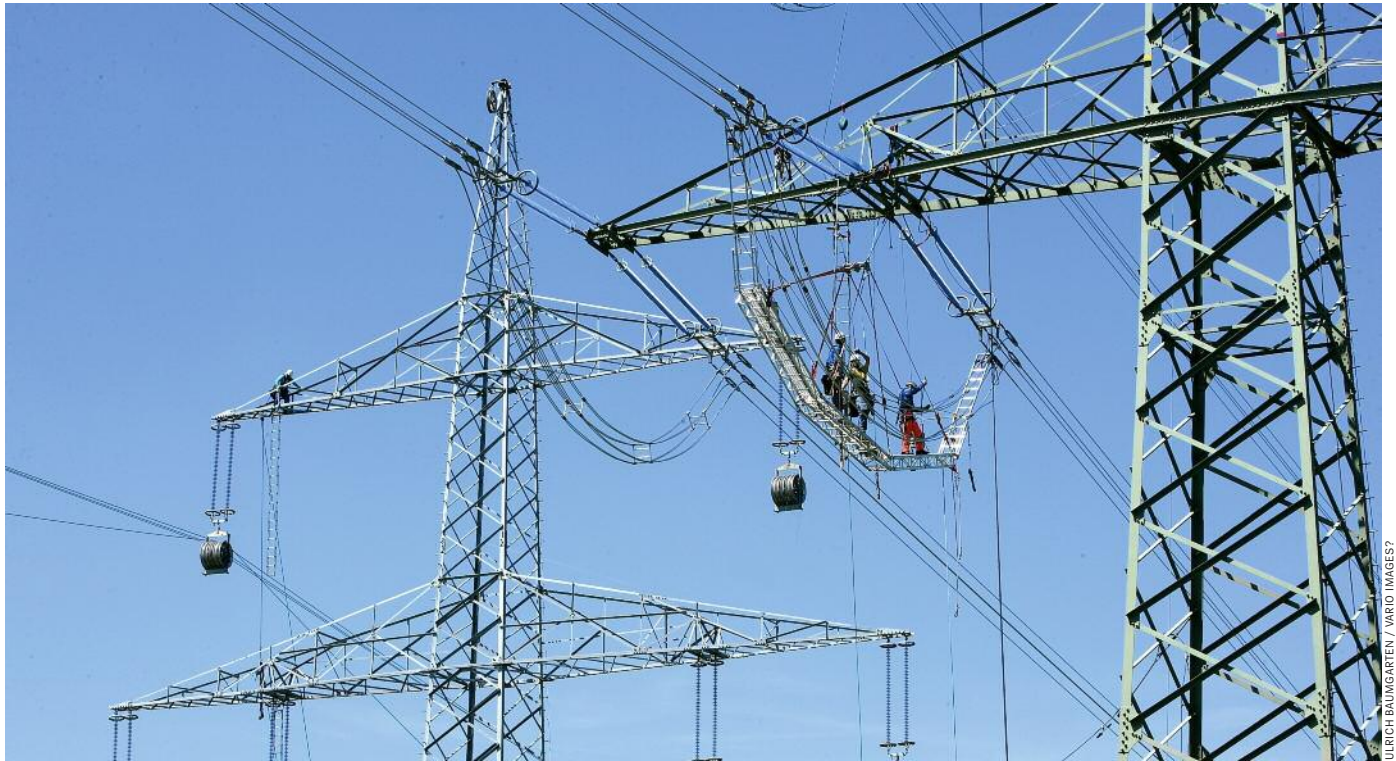
Arbeiten an Hochspannungsleitungen
