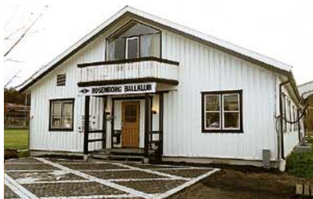
Rosenborg-Clubheim: Sieben Tage ein offenes Haus
