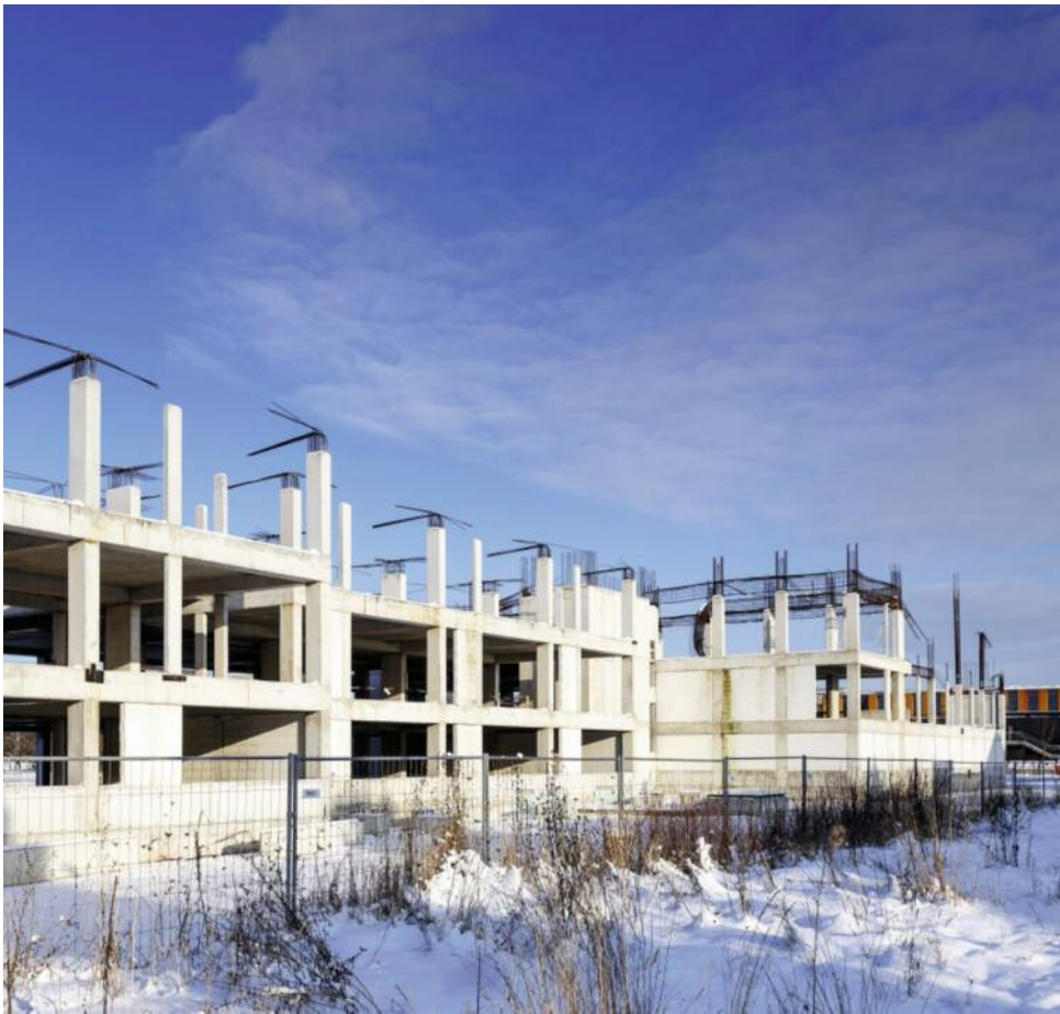
Rohbau der griechischen Schule in München: Ein Meter dicke Bodenplatten
