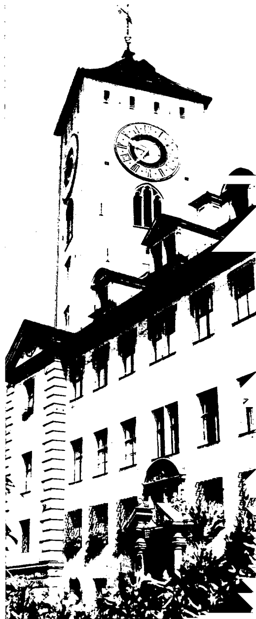
Turmuhre am Rathaus von Regensburg ... von vergoldeten Zeigern
