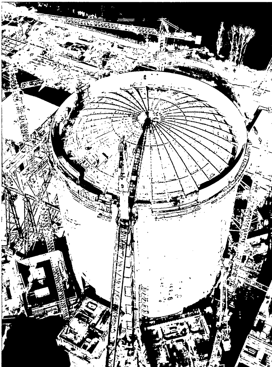
Baustelle des Super-Phénix-Brüters in Frankreich: 15 Jahre voraus?
