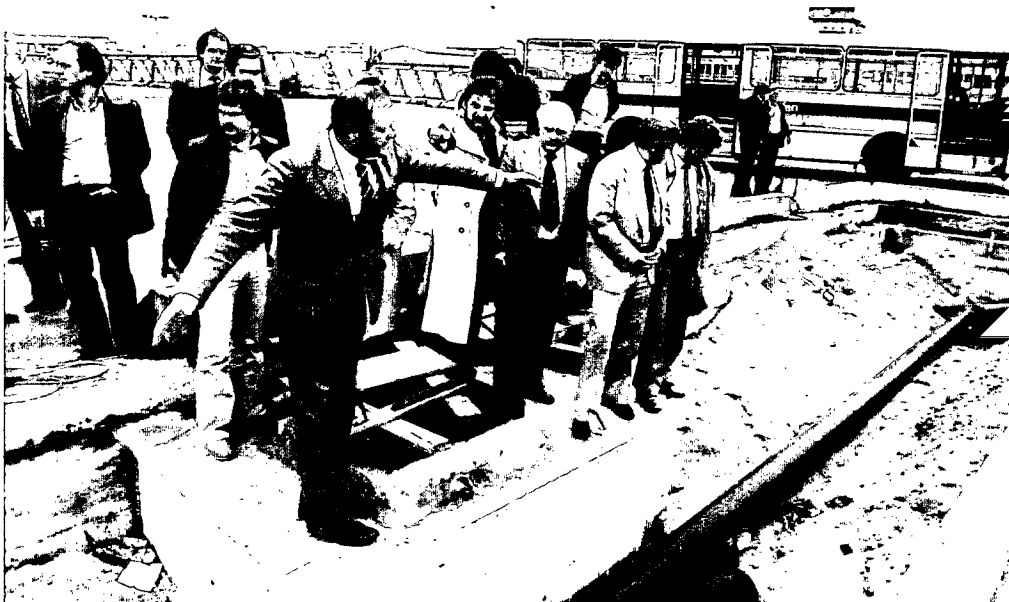
Defekte Kerosinleitung in Frankfurt*: Gefahr am Hinkelstein
