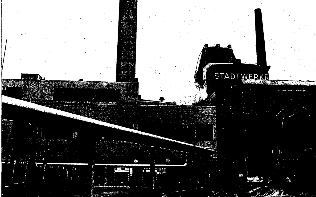
Kraftwerk in Flensburg: Im Vergleich zu Öl und Gas zahlen die Kunden nur die Hälfte
