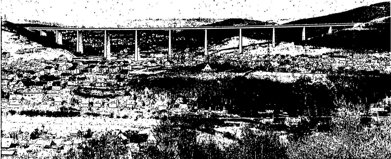
**Spannbeton-Brücke über das Siegtal (Sauerlandlinie): „Schlanke und anmutige Konstruktionen ...**
