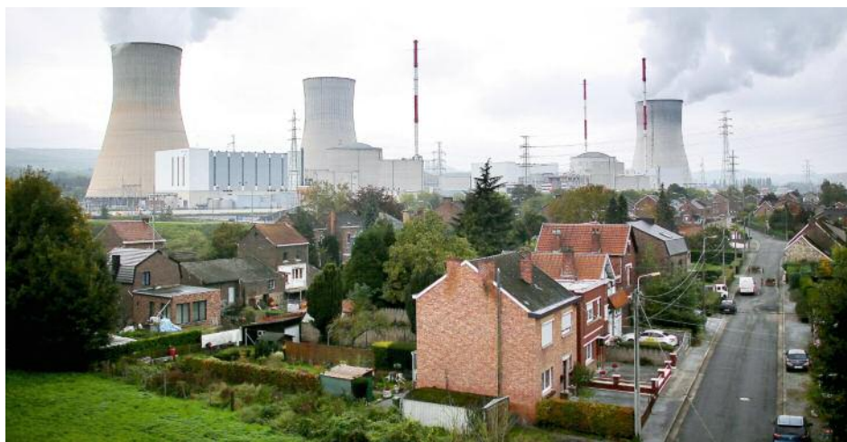
Kraftwerk Tihange: Tausende kleine Risse
