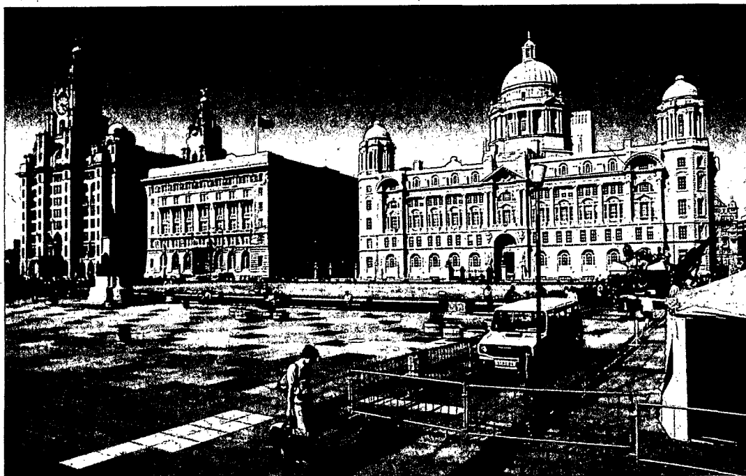
Liverpool, Hafensperrmauer: Unverrückbare Festungen
