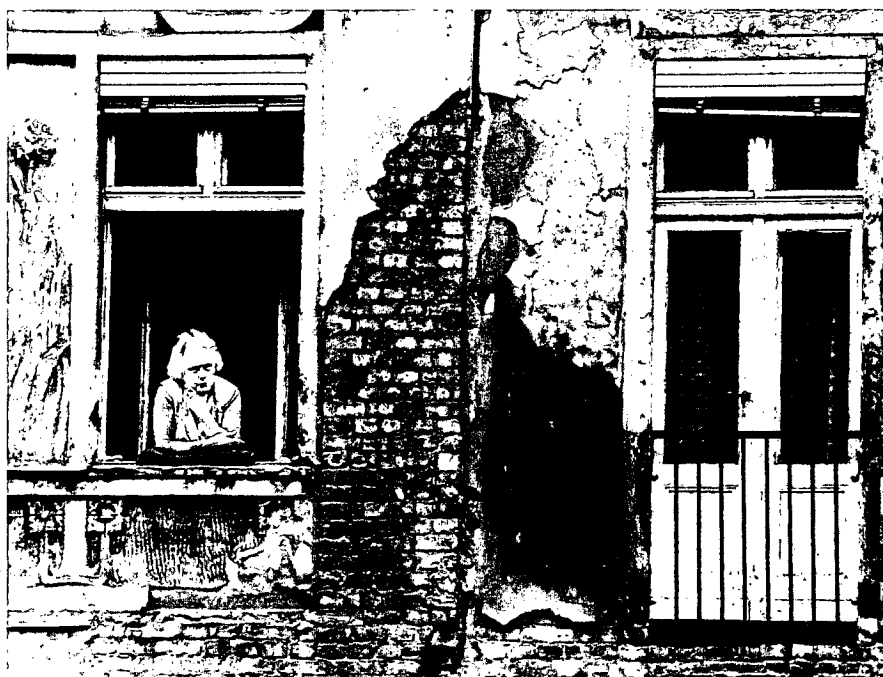
Sanierungsbedürftige Häuser am Prenzlauer Berg in Berlin
