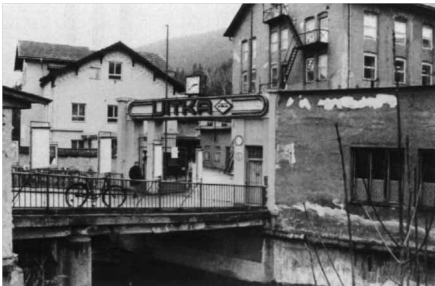
Ehemalige Schindler-Fabrik in Brněnec: Rettender Hafen
