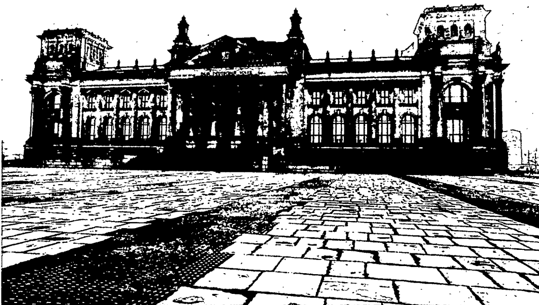
Reichstagsgebäude in West-Berlin: Schandflecken beseitigt
