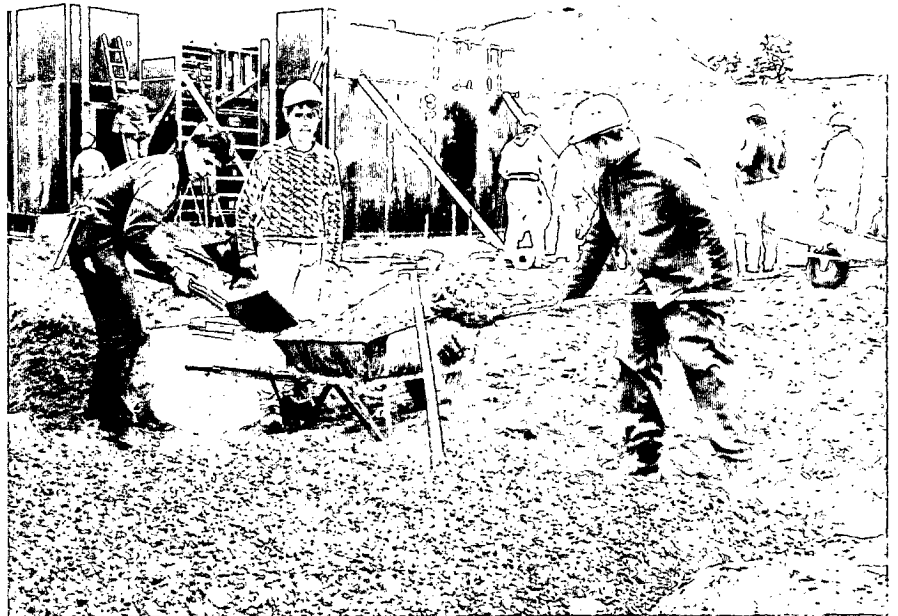
Neubau eines Einkaufszentrums in Schwerin: „Meine Erfolgsbilanz“
