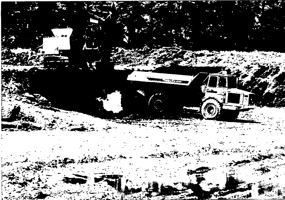
Bodensanierung in Trünzig: „Vielleicht waren die Alten einfach robuster“
