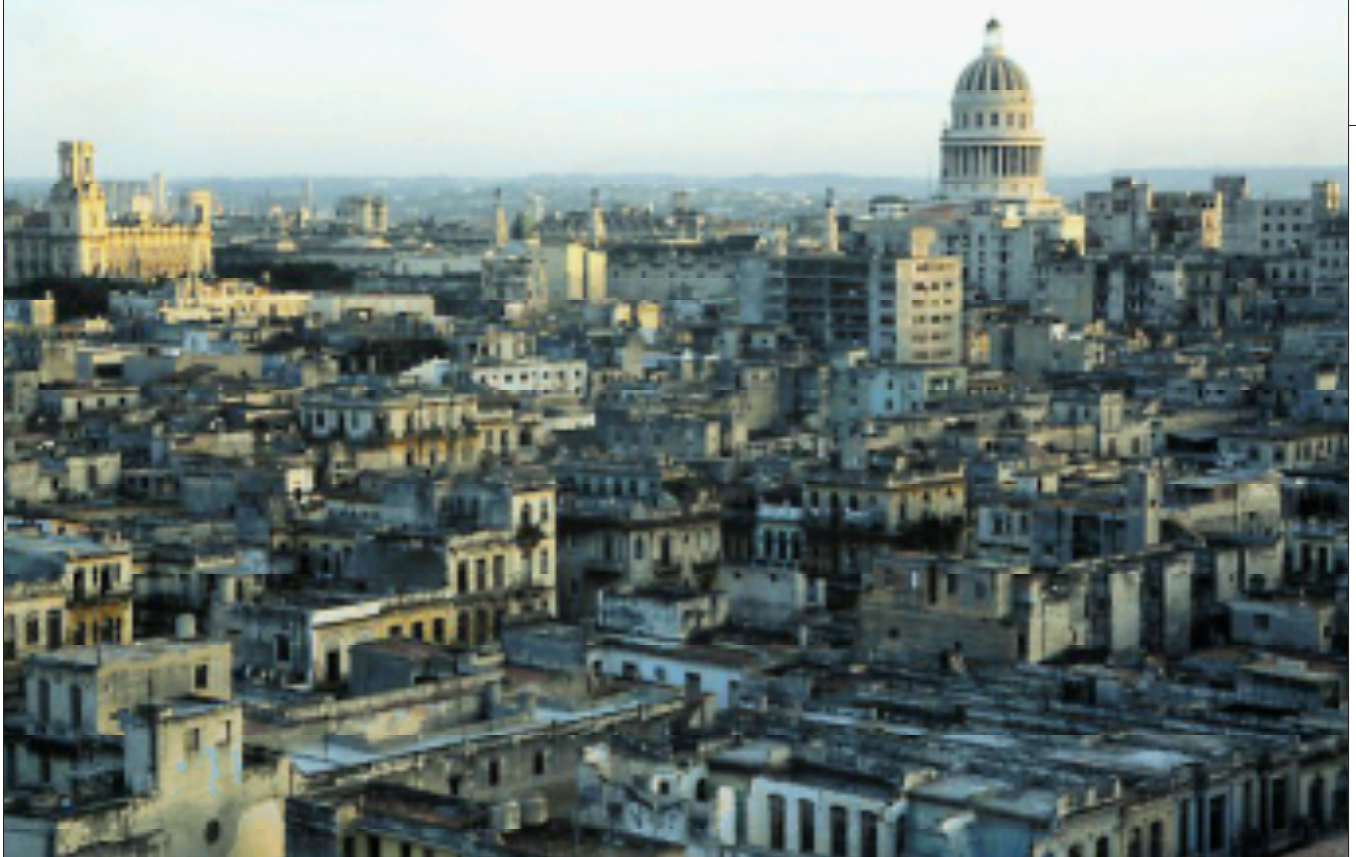
Verrottende Bauten im Herzen der Hauptstadt: Jeden Tag stürzen durchschnittlich anderthalb Gebäude ein
