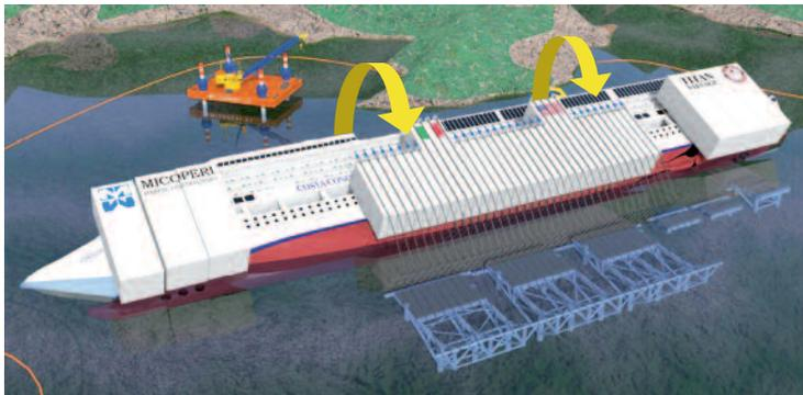
**Frühjahr 2013:** An Schwimmkästen und Plattformrand werden 36 Stahlseile befestigt. Hydraulisch betriebene Spannelemente („Strand jacks“) ziehen das Schiff aus der Seitenlage („Parbuckling“).
