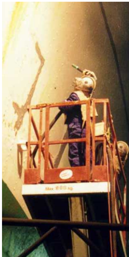
Kugelstrahlbehandlung am Schiffsrumpf* Enorme Schockwellen
