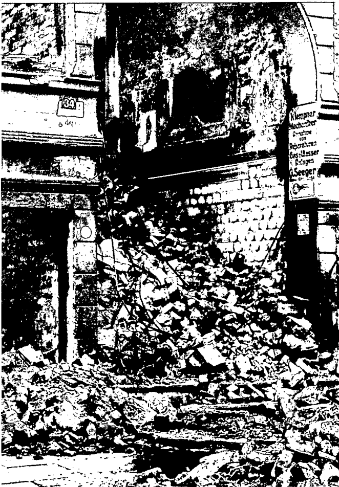
Hauseingang mit Markierung für Suchtrupps
