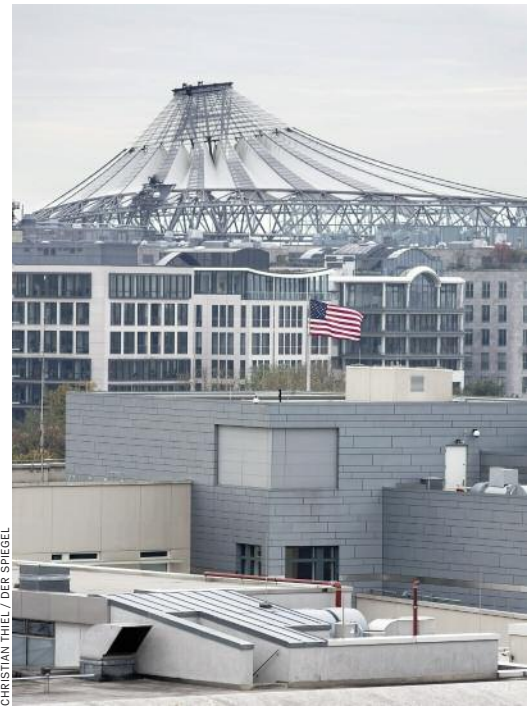
Dach der US-Botschaft in Berlin Sichtblenden für die Abhörtechnik
